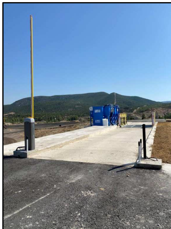
Figura 4.4.4/I: Impianto lavaggio ruote
